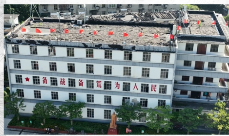
04兰一区生活公司宿舍楼
